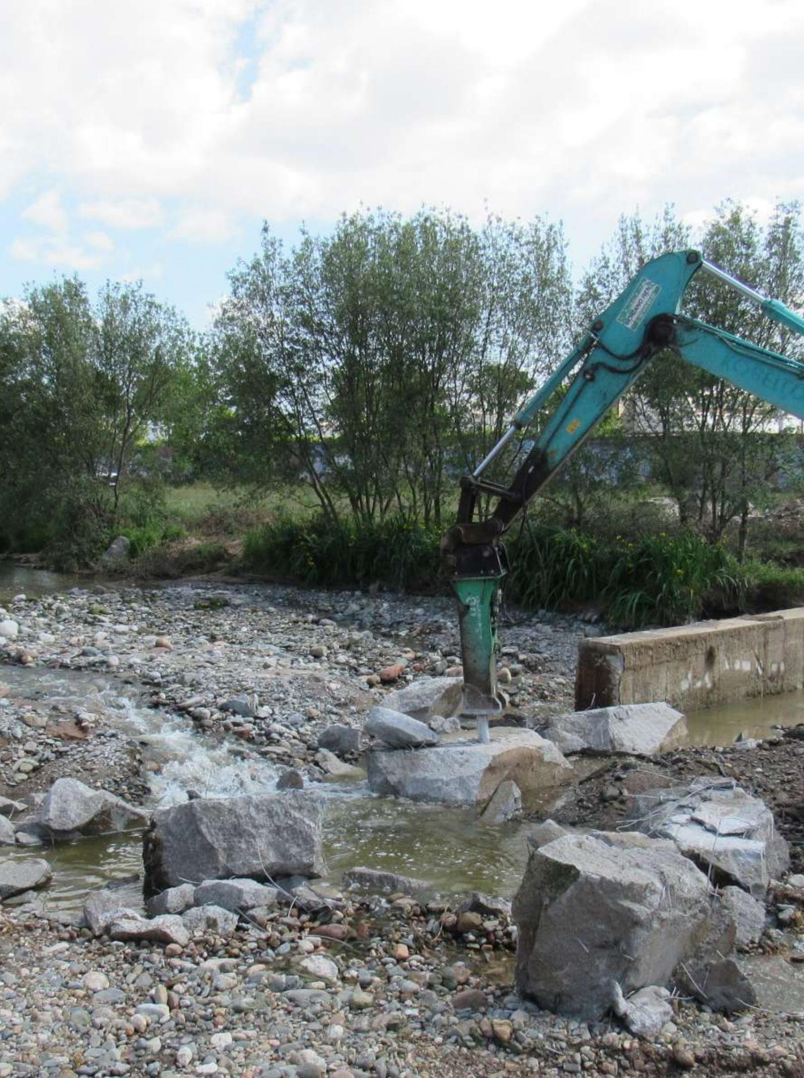
Restauración del transporte de sedimentos y de la inundación lateral con la retirada de la canalización y de un azud obsoleto (río Congost en Granollers, cuenca del Besòs) / Foto: Aprèn Serveis Ambientals
